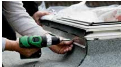
Profile mocujące pokrycie dachu do okna ZZZ 210
