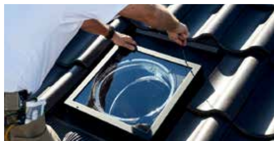
Montaż od strony dachu zapewnia wyjmowane skrzydło
